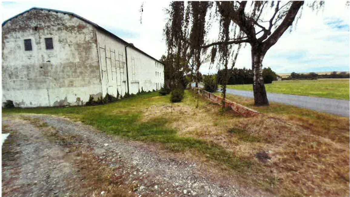
3. fasáda – výrobní část
